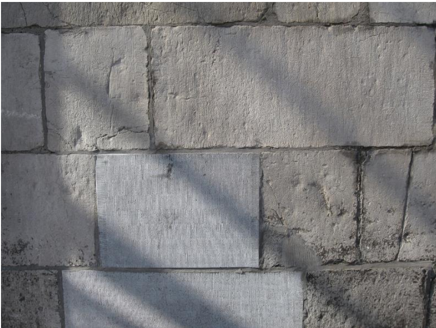
De oude blokken Naamse steen aan deze gevel zijn eerst met de hand vlak gemaakt en daarna pas gefrijnd. Recente vervangingen met lerse hardsteen (midden en middenonder) zijn vlak gezaagd en daarna gefrijnd. Het eindresultaat sluit niet goed aan bij de oorspronkelijke omgeving, omdat het de onvolkomenheden van het handwerk mist en het materiaal anders is. Een voorbeeld van 'Imiteren'.
